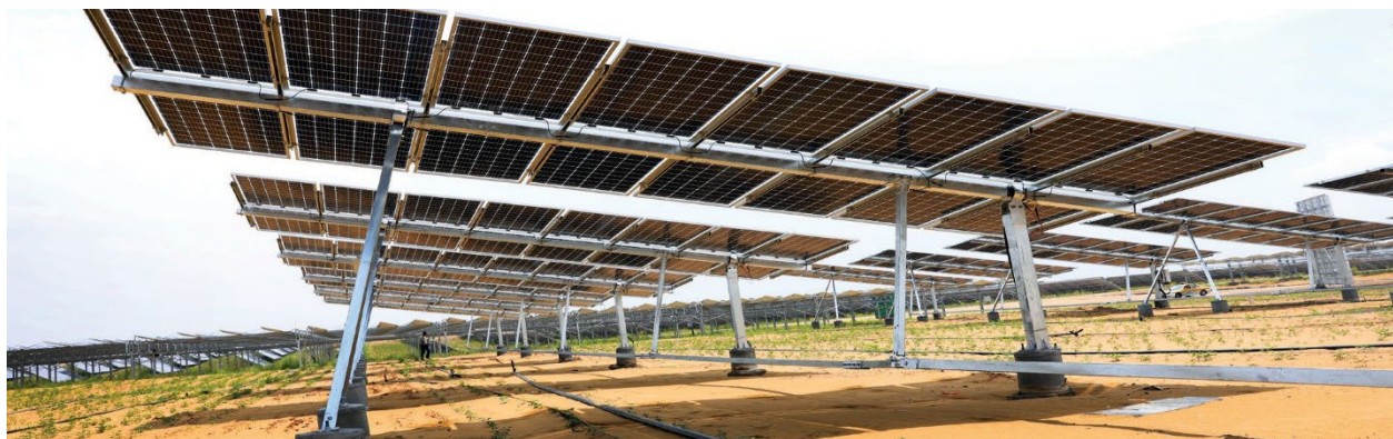
Obrázek 7 Instalace bifaciálního modulu pomocí šroubů
